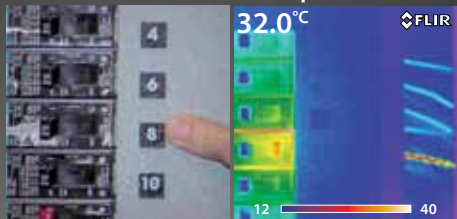
Les mauvaises connexions sont invisibles à l'œil nu mais visibles sur l'image thermique.
