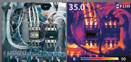
Détection des problèmes dans les installations électriques pour éviter les pannes.
